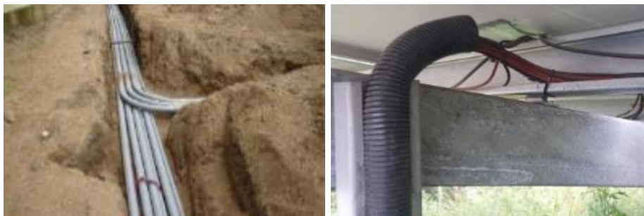
Figura 7. Cableado terrestre recubierto con tubería impermeable Figura 8. Sistema de cableado recubierto con tubería aislante para evitar la intemperie.
