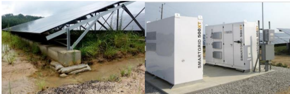
Figura 5. Trinchetes y bases para la estabilización y elevación de paneles en zonas inundables. Figura 6. Terraplén para la instalación de los gabinetes en zonas inundables.
